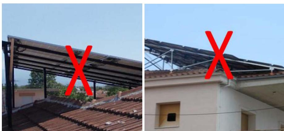
Αν τα φωτοβολταϊκά τοποθετούνται σε δώμα, θα πρέπει η απόσταση από το στηθαίο του δώματος να είναι κατ' ελάχιστο μισό μέτρο για λόγους ασφαλείας.
